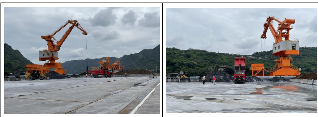
图 2.2.8-4 装卸车现状照片
