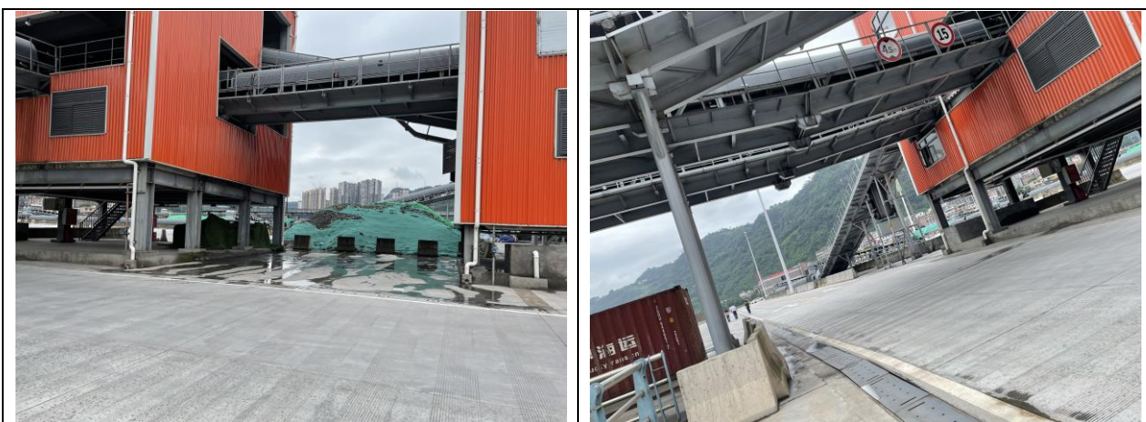
图 2.2.8-3 后方配防尘罩的带式输送机水平运输现状照片
